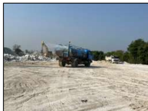
รูปที่ 2-10 การฉีดพรมน้ำบริเวณที่เกิดฝุ่นละออง ทั้งบริเวณหน้าเหมือง และเส้นทางขนส่งภายในพื้นที่ เพื่อลดการฟุ้งกระจายของฝุ่นละออง
